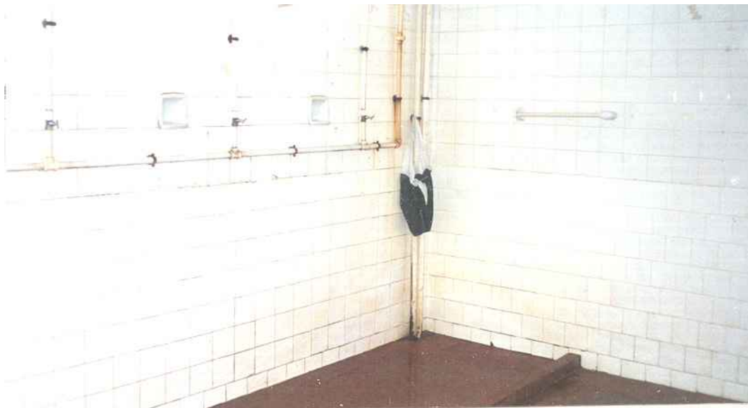
Cronos (Fotografia do banheiro do 3º alojamento masculino – 3º andar)
