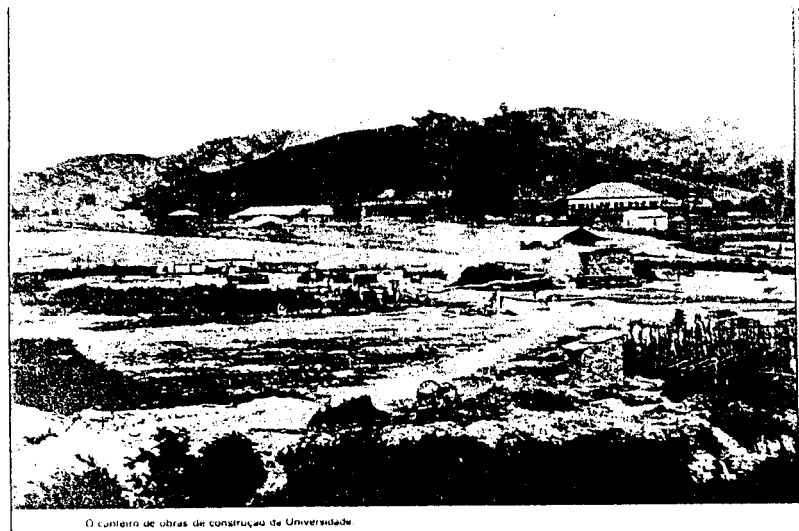
Construção da ESAV 77 .
