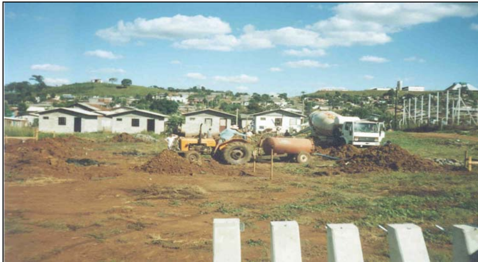
Início construção pavilhão da ARCAN, março de 2002
