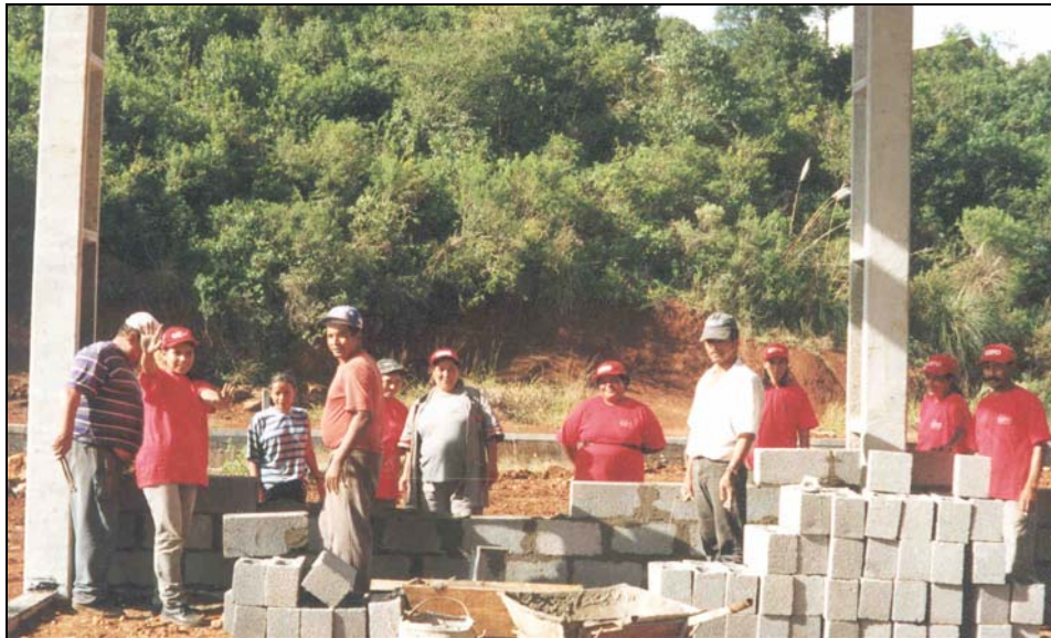
Mutirão de construção da sede da ARCAN, pelos associados/as
