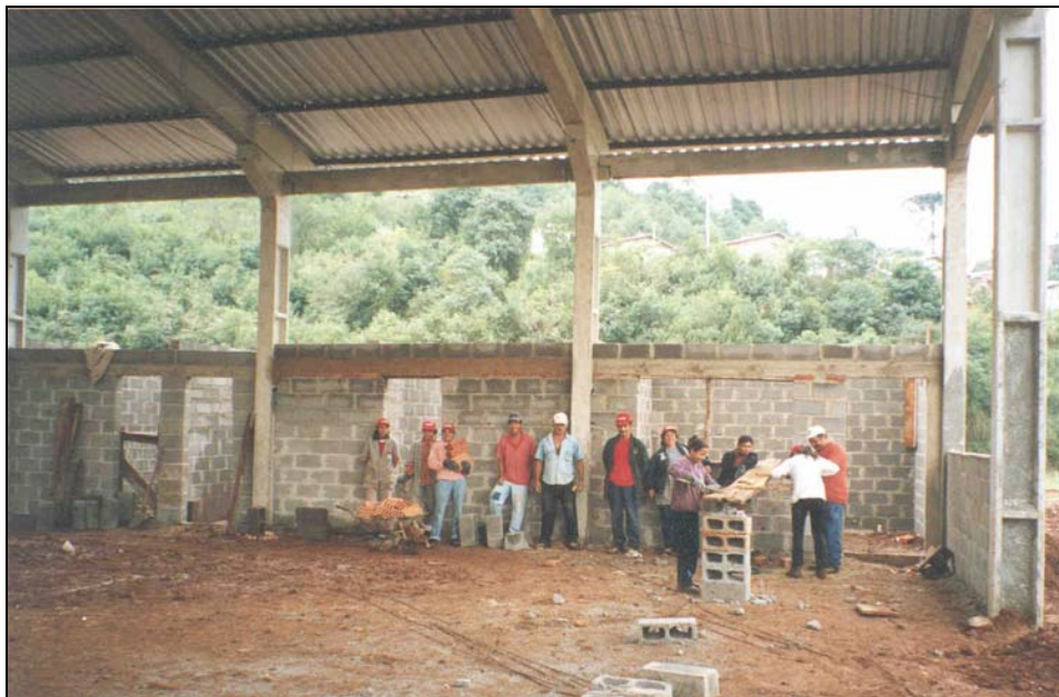
Mutirão de construção da sede da ARCAN, pelos associados/as
