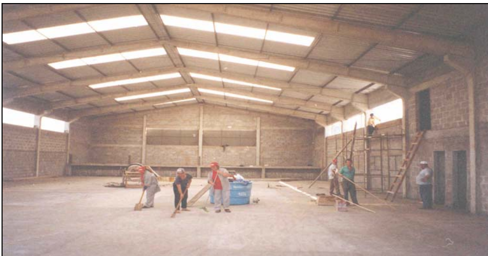
Fase final de construção da sede da ARCAN
