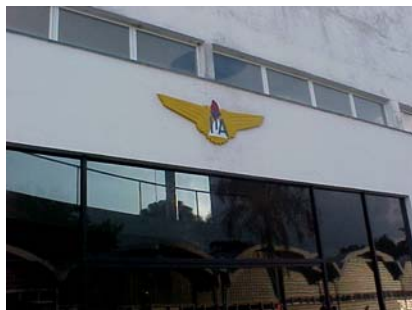
Figura 2 Aspecto Frontal da Fachada do Prédio do ITA.
